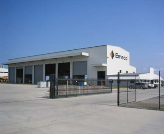
Emeco Premises – Mackay, QLD
